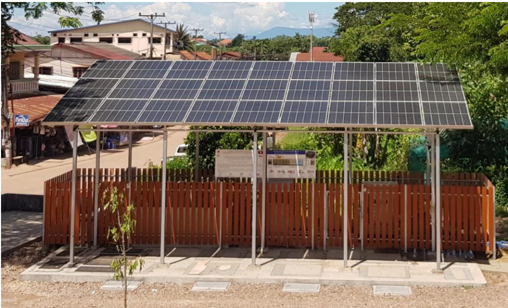
ຮູບພາບ 2.5-13 ລະບົບບໍາບັດນໍ້າເປື້ອນທີ່ໃຊ້ ວັດສະດຸໃຊ້ຄືນ KIDS ແລະໃຊ້ພະລັງງານແສງຕາເວັນ ທີ່ ສູນອາຫານມະຫາວິທະຍາໄລແຫ່ງຊາດ
