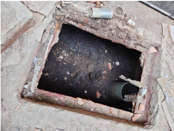
ຮູບ 0.1-1 DEWATS ເຕັມໄປດ້ວຍຕະກອນ ເນື່ອງຈາກຂາດການບຳລຸງຮັກສາທີ່ເໝາະສົມ.
